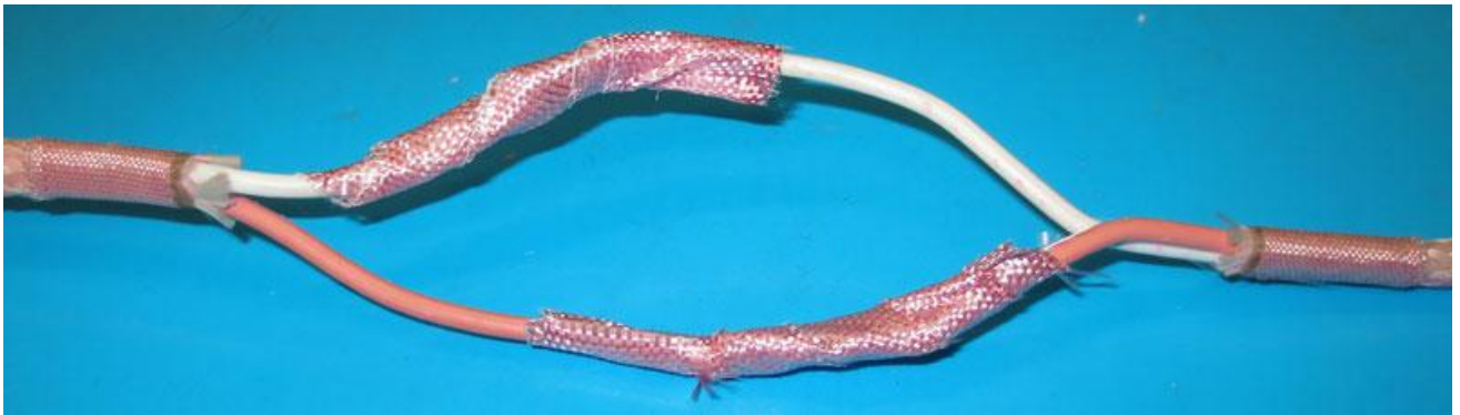
Рис. 30. Изоляция кабеля лентой термостойкой ЛТ «Гефест».
