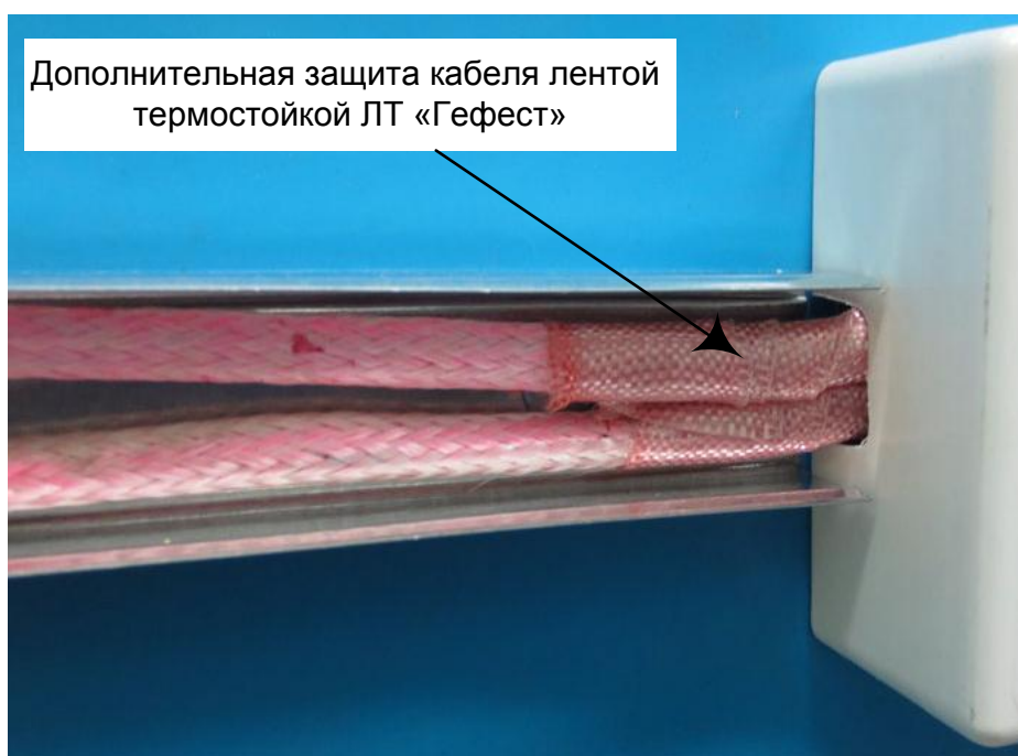
Рис. 24. Пример установки КМ-О с примыканием кабельного канала.
