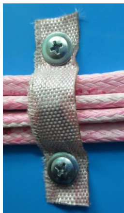
Рис. 6. Установка дюбель–хомута КФСТ.735322.041 и КФСТ.735322.164. Вариант 2.
